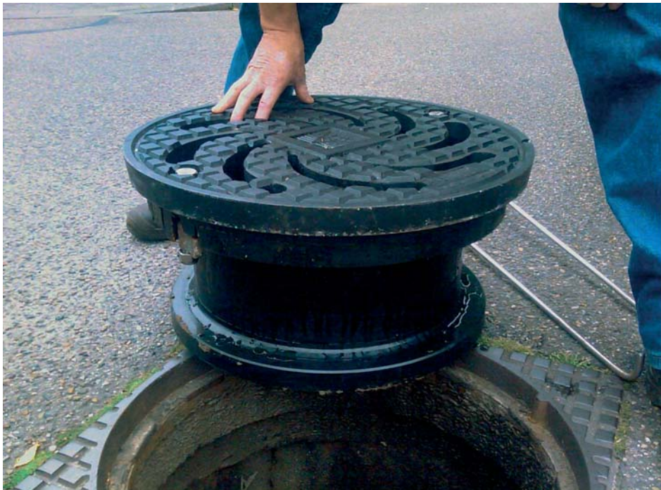
Figuur 17.20 Plaatsing van een ontluichtingsputdeksel (Bron: TBS)
